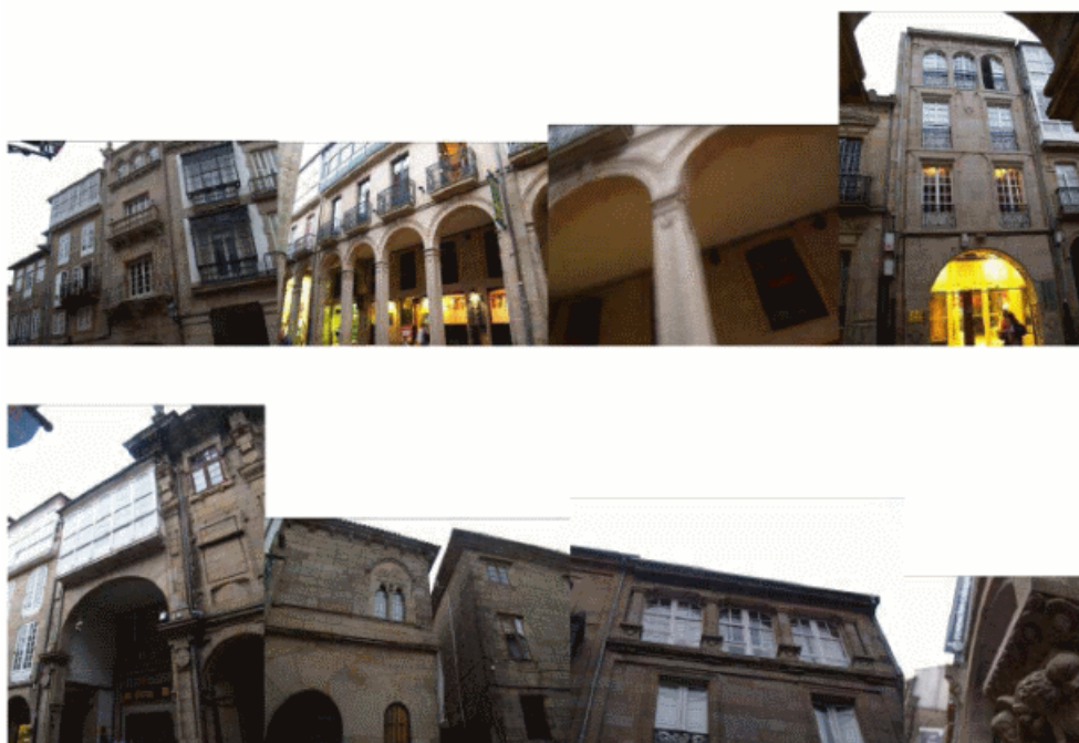
(FIG. 4-11: EDIFICIOS REVIVALESICOS EN SANTIAGO DE COMPOSTELA, PRAZA DE CERVANTES, RÚA DO VILAR Y SAN MARTIÑO)
