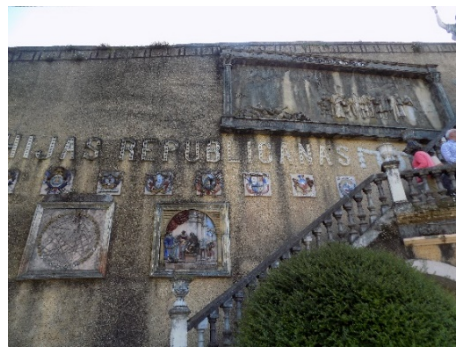
Figura 32. Escaleras de acceso al segundo nivel.
