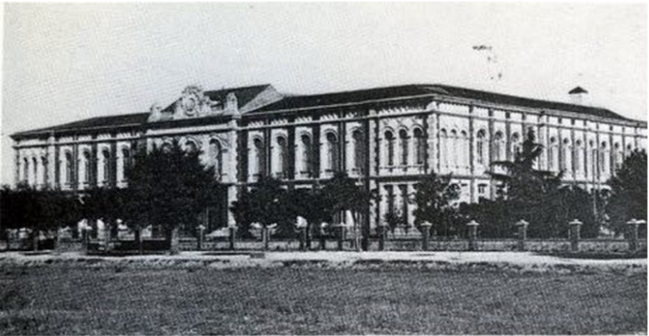
Figura 1. Instituto Claudio Moyano antes de la reforma.
