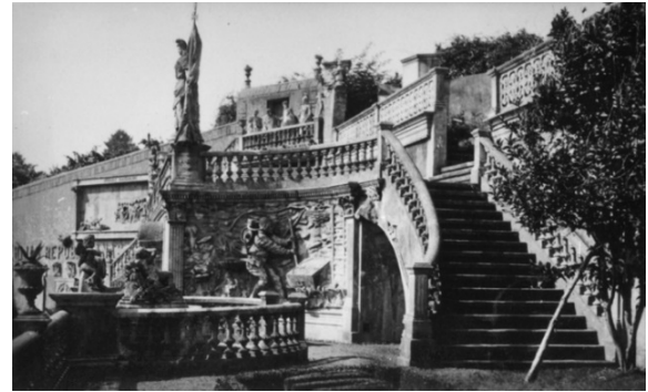
Figura 42. Escaleras de acceso al segundo nivel. Loty (1927-1933).
