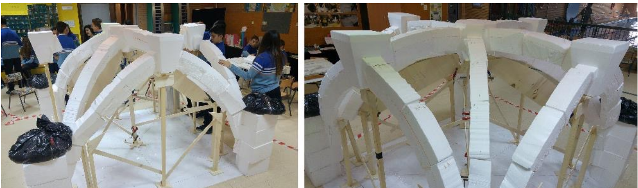
Figura 6. Montaje de la bóveda
