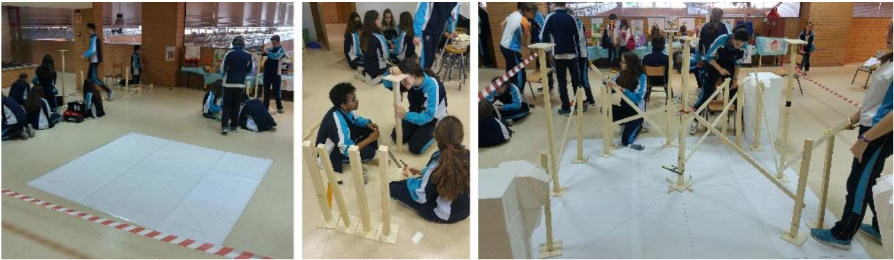
Figura 5. Montaje de la estructura auxiliar de madera para la construcción de la bóveda
