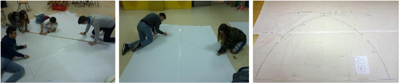
Figura 1. Dibujo de la planta y los alzados de los arcos de la bóveda en el taller del colegio Ártica.
